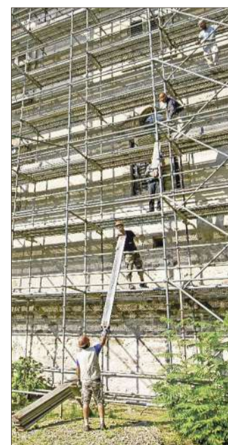
... an den Außenwänden ist in Arbeit. Fotos: Zeindler-Effer
