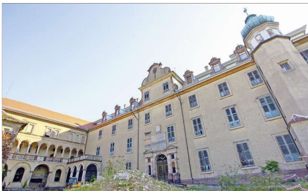
Die dem Hof zugewandten Fassaden des Neuen Schlosses auf dem Florentinerberg sind bereits vom Gerüst befreit worden, der Abbau ...
