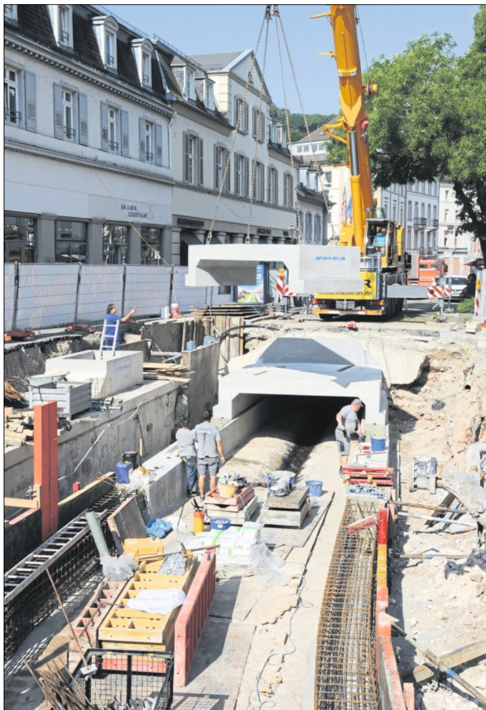
DECKEL AM HAKEN: Gestern sind die ersten fünf Fertigteilelemente als neues Dach des Rotenbachkanals eingesetzt worden. Foto: Kappler
