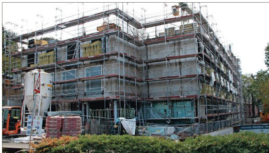
Rohbau schreitet voran: Trotz mancher Materialengpässe gewinnt das „Hotel an den Thermen“ immer mehr Gestalt.
